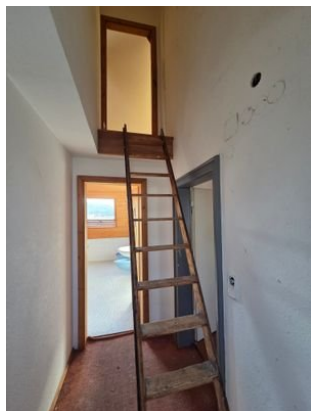
Treppenhaus 2. OG Aufstieg DG
